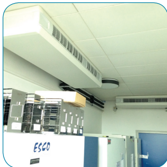
Zwei Gebläsekonvektoren
